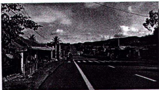
CÔNG TRÌNH MỞ RỘNG QUỐC LỘ 1
